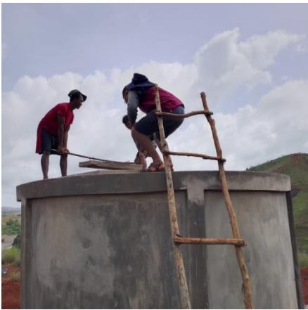
Chantier à Marokoro – Madagascar 2025
